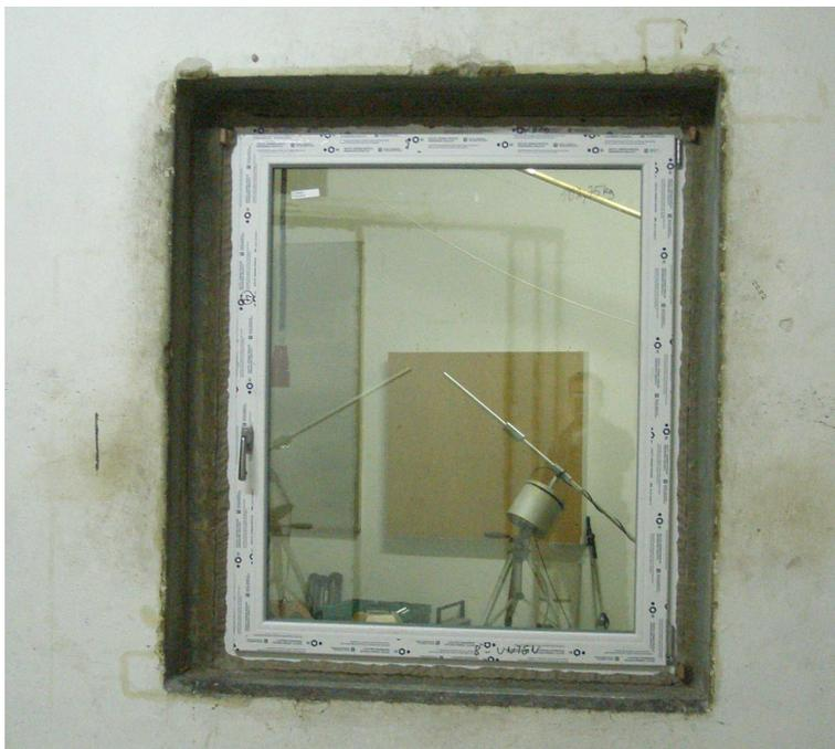
**Bild 1** Foto des eingebauten Elementes, erstellt vom ift Schallschutzzentrum
